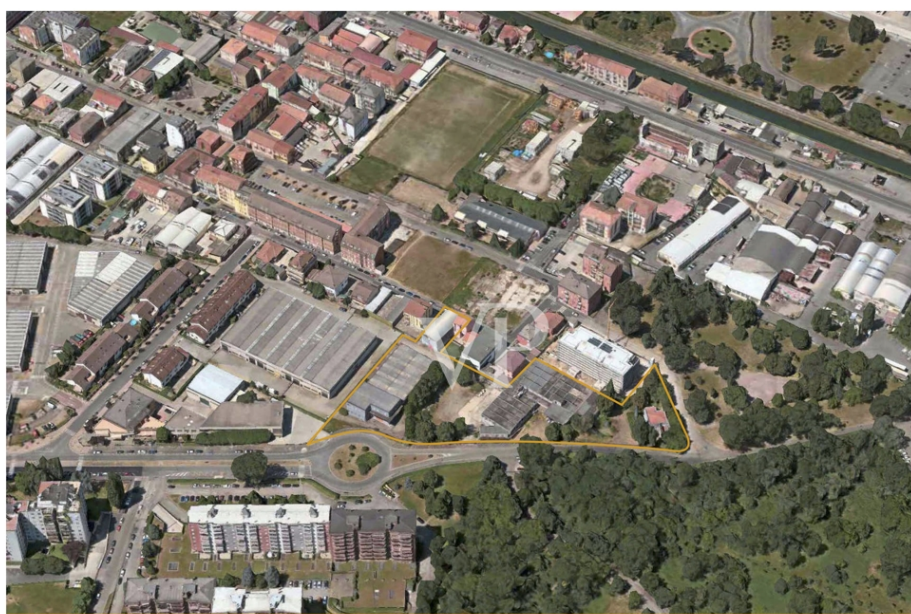
FOTO AEREA CON PERIMTRAZIONE AREA D' INTERVENTO
